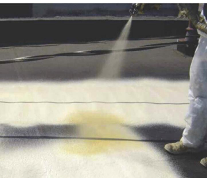
**DuraTite CC** est un système de mousse de polyuréthane pulvérisée conçu pour les toits à faible pente, résidentiels et commerciaux. Il est facile à appliquer et développe une protection extérieure lisse qui aide à maximiser la couche de finition. Lorsqu'il est installé en conjonction avec une couche de finition approuvée, DuraTite CC fournit un système de toiture durable avec toutes les informations d'identification UL 790.
